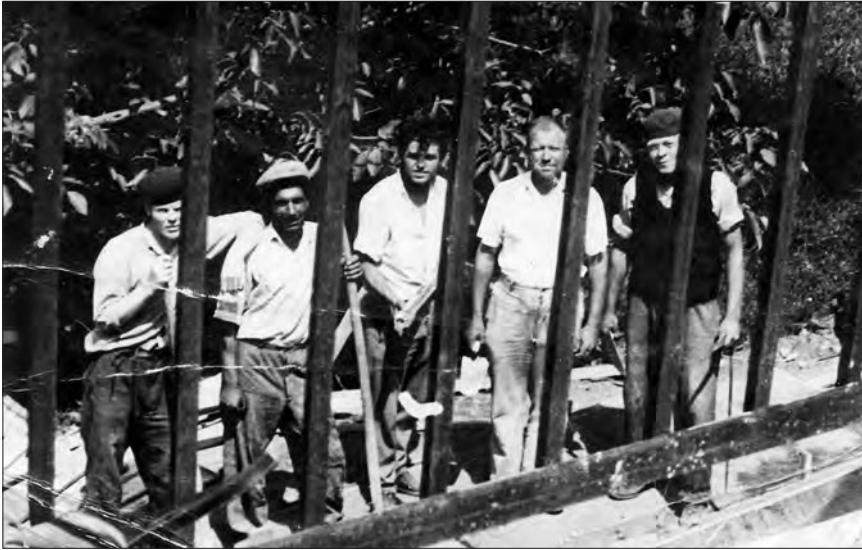
Rudolf Bukovits during construction of the Sió canal, 1947
